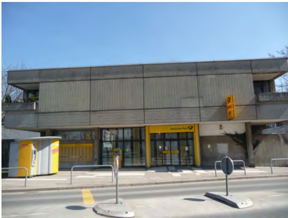
Nr. 9: Wohngeschäftshaus (Post) Hochzoller Str. 5 2-gesch. Schüttbetonbau Ende der 60-er J. Flach-dach mit optisch „aufgelöstem“ öffentlichem Be-reich und symmetrischen geöffneten Fassaden-ecken im OG. Klar strukturierte Symmetrie, reduzierter Gestal-tungsduktus. Dokument des städtebaulichen Um-bruchs in Hochzoll.
