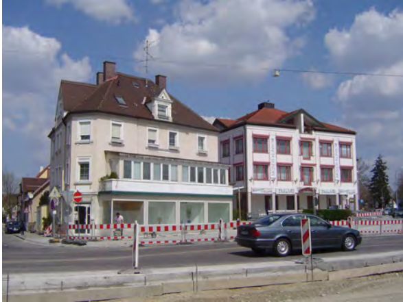
Nr. 7: Wohn-Geschäftshaus, Friedberger Str. 151½ 3-gesch. niedriger Eckbaukörper mit durchlaufendem Satteldach und langgestrecktem Verandavorbau und Gesims über dem EG.. Fenster mit Putzfaschen.
